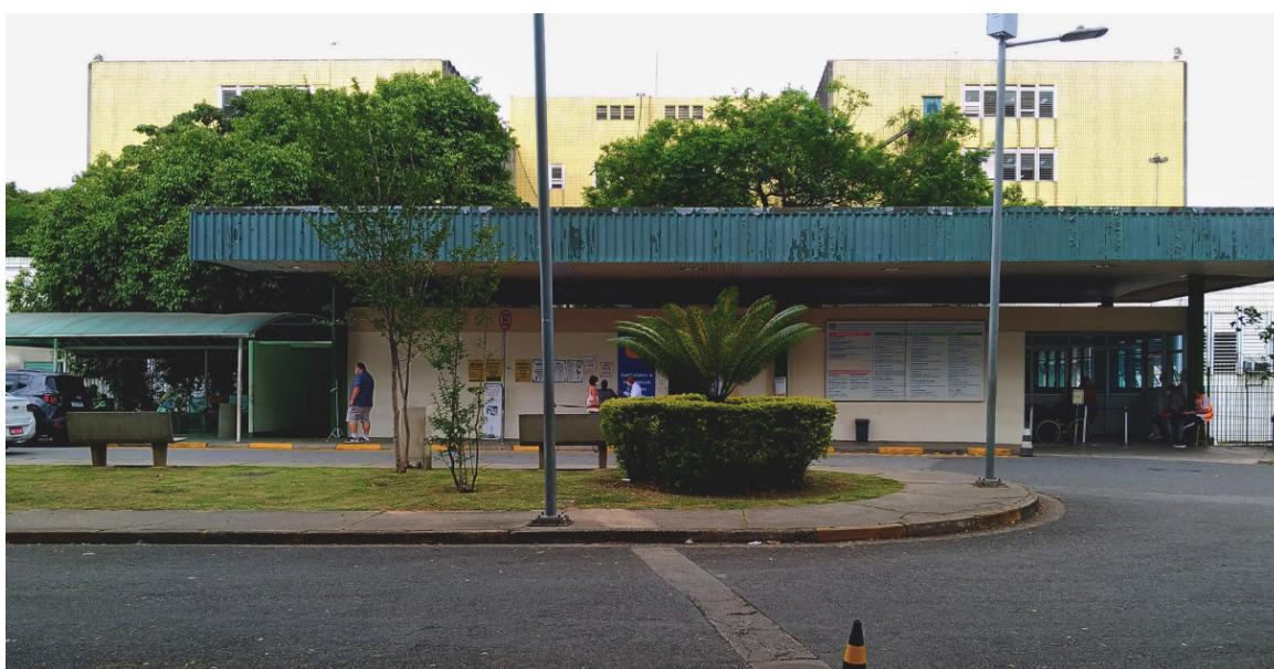
Figura 4 . Acceso al pabellón administrativo y acceso de atención al público. Fuente: los autores.
