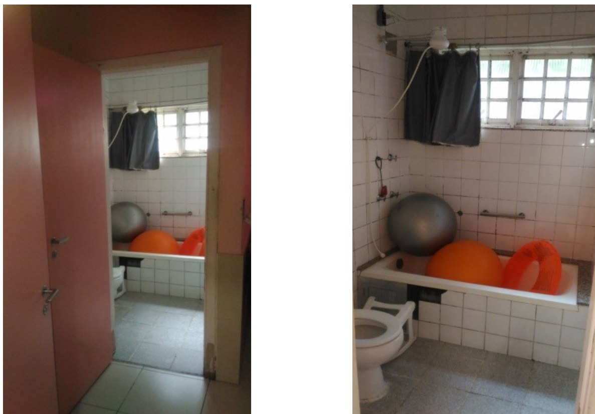
Figura 18: Banheiros de quarto PPP
