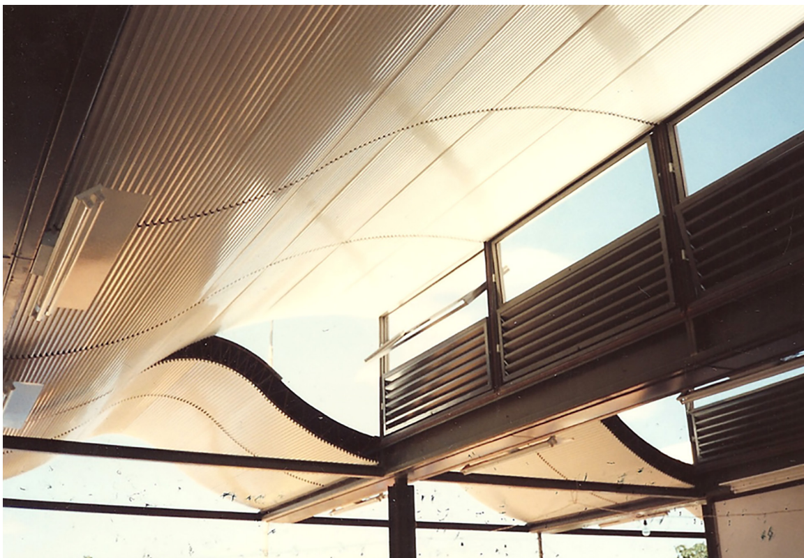
Imagem 15. Sarah/BA – vigas duplas com luminárias acopladas, vigas de amarração e cobertura em fase de montagem: primeiro plano com “shed”; ao fundo, sem “shed” (para varandas e locais climatizados).
