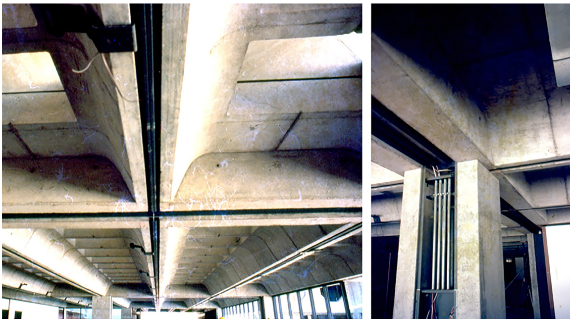
Imagens 05 e 06. Sarah/DF – lajes nervuradas com canaletas para fiações; vigas e pilares duplos para passagem de instalações diversas.
