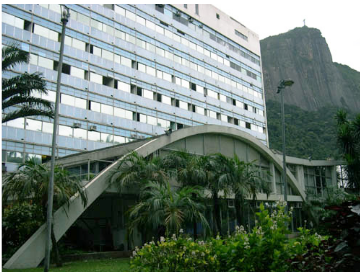
Figura 5. Fachada este del Hospital da Lagoa. Fuente: Rio de Janeiro – NEMS, 2012.
