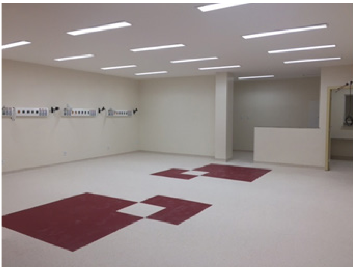
Figura 4. Instalación de las láminas de vinilo. Fuente: Autoría propia (2017).
