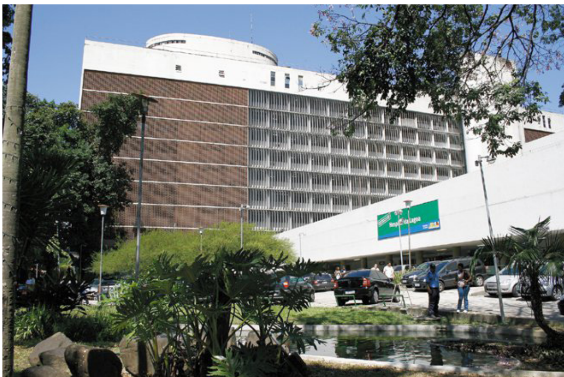
Figura 6. Bloque del dispensario, Hospital de la Lagoa. Fuente: NEMS, Rio de Janeiro, 2016.
