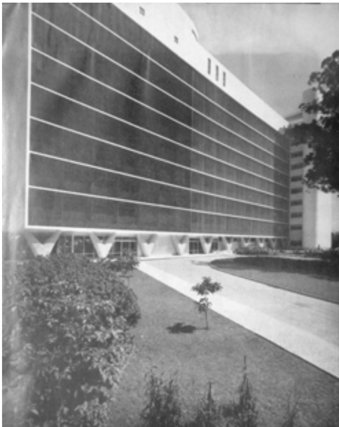
Figura 8. Fachada oeste del Hospital da Lagoa. Fuente: Módulo, Revista de Arquitectura y Artes., 1959.
