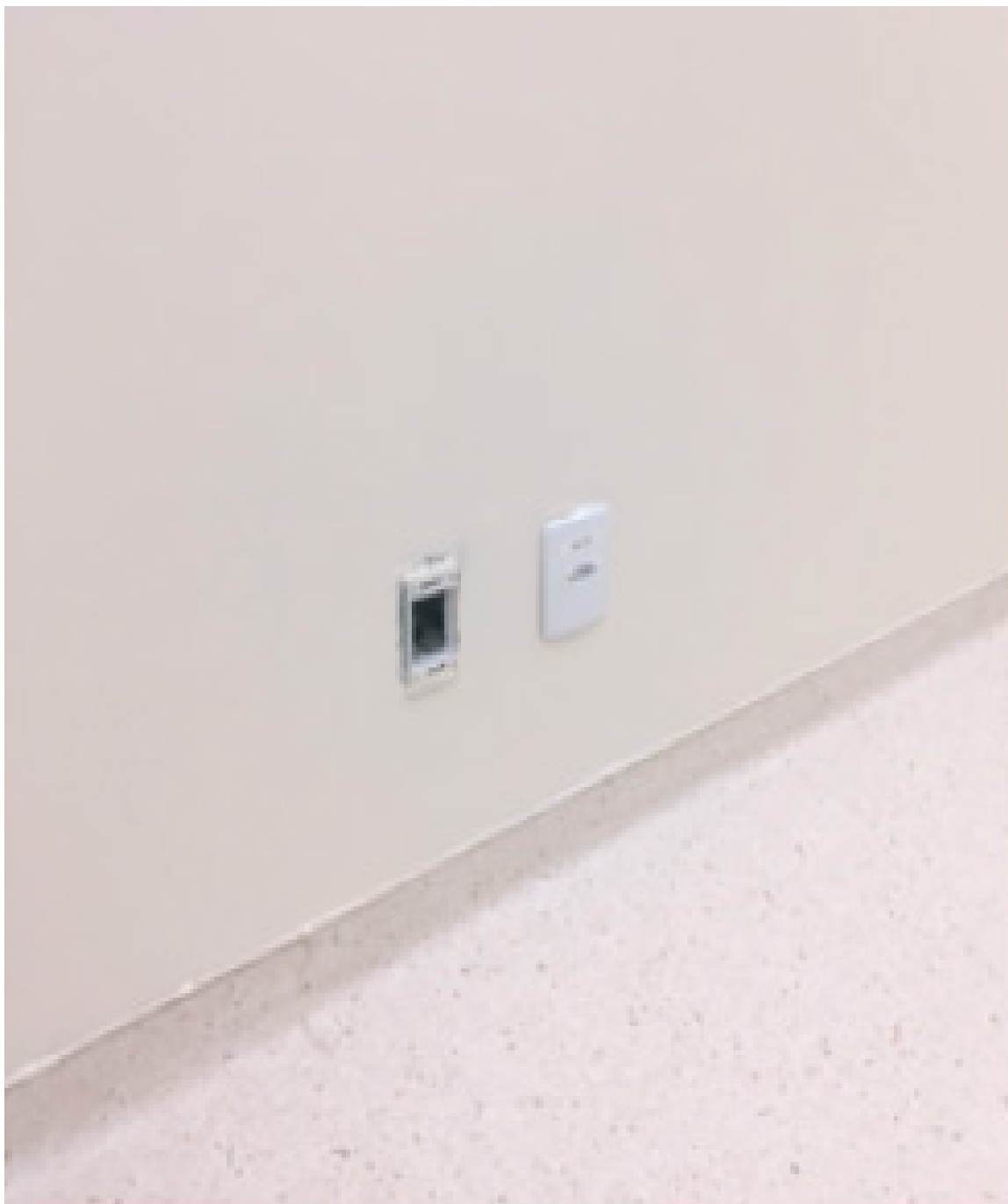
Figura 5. Detalle del zócalo y de la cola de silicona. Fuente: Autoria propia (2017).
