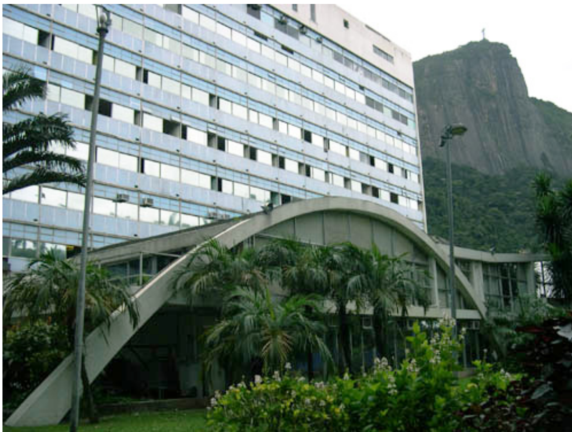
Figura 5. Fachada leste do Hospital da Lagoa. Fonte: Rio de Janeiro – NEMS, 2012.
