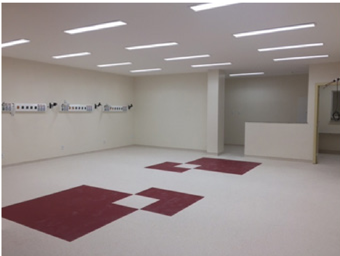
Figura 4. Instalação da manta vinílica. Fonte: Autoria própria (2017).
