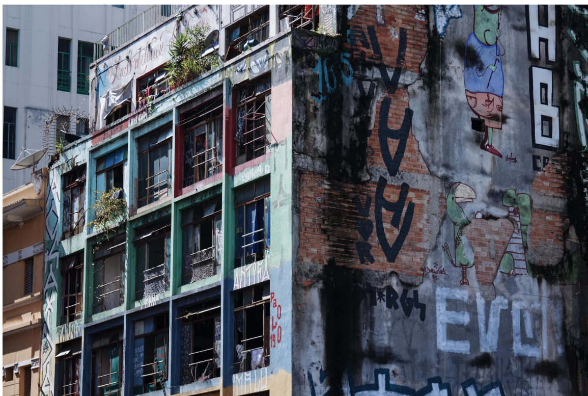
Figura 4. Edifício abandonado e invadido no centro de São Paulo. Fonte: Exarte (2019).
