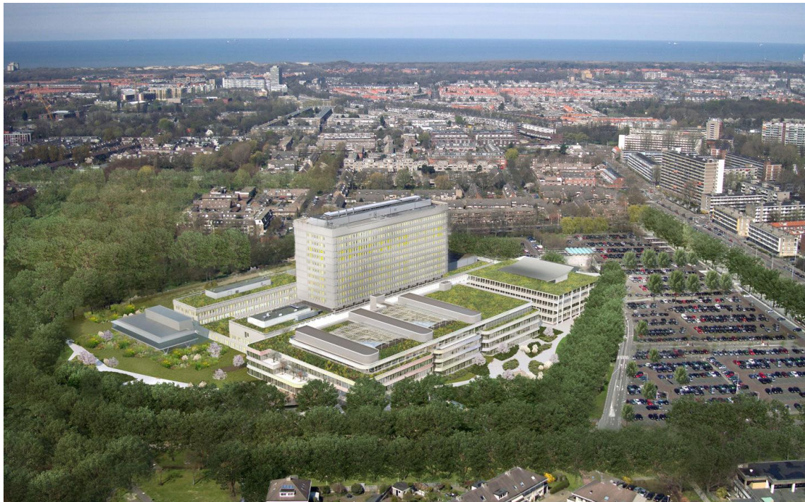
Figura 8 - Implantação privilegiando a proteção paisagística e acústica no entorno do Haga Hospital (930 leitos), Haia, Holanda – The Volker Wessels Haga Consortium. Fonte: http://www.heartbeat5.nl/facilities.asp?Service=Haga%20Hospital&ID=4 , 2014.
