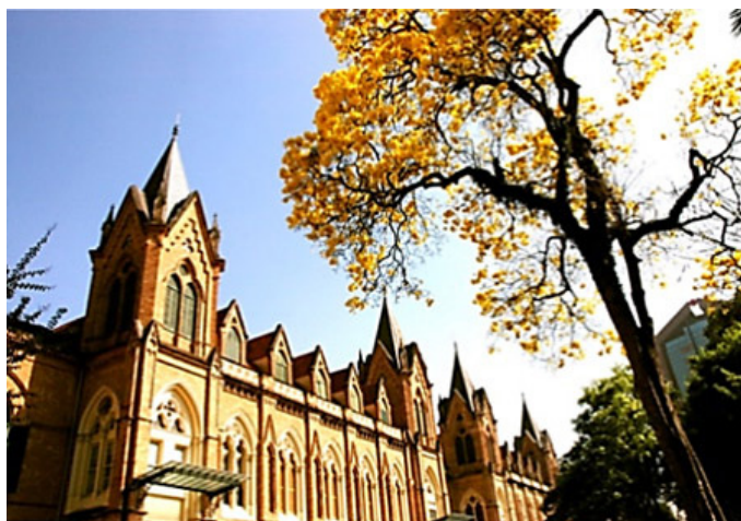
Picture 01 – Santa Casa de Misericórdia de São Paulo Hospital - (2015).
