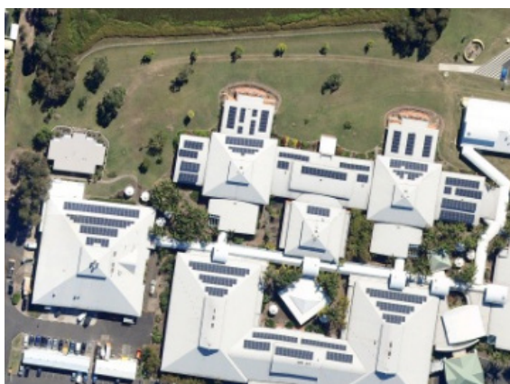
Figura 19: Sistema conectado à rede de 266kW com 38 inversores string em Pialba, na Austrália, que contou com projeto fotovoltaico desde sua concepção e foi otimizado para receber o SFVCR Fonte: ABB, 2013
