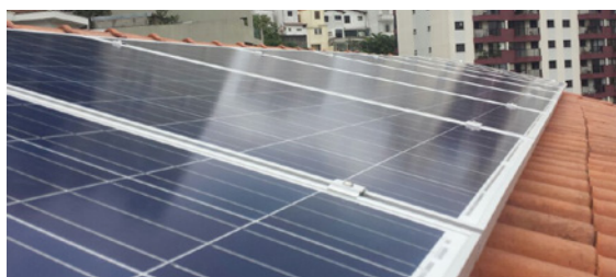
Figura 20: Sistema fotovoltaico conectado à rede com 2,34 kWp de painéis e 3kW de inversor, localizado em São Paulo, Brasil, na sede do Instituto de Pesquisas Hospitalares Jarbas Karman Fonte: Solstício Energia, 2016
