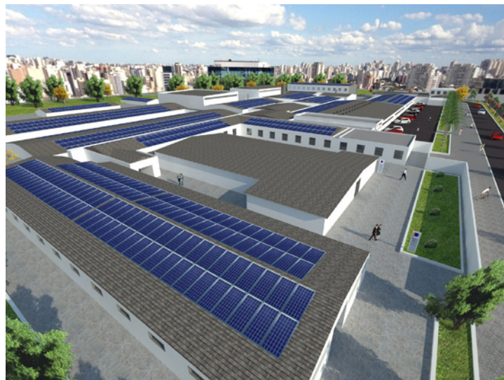
Figura 22: Sistema conectado à rede de 650kW com 11 inversores string em Araguaína, Tocantins, em imagem ilustrativa que compõe o projeto fotovoltaico
