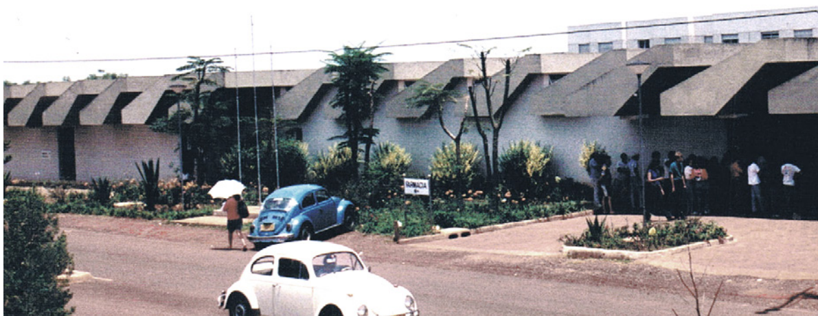
Imagem 34: Cobertura em Sheds - Hospital Regional São José Fonte: Acervo IPH / Coleção Irineu Breitman
