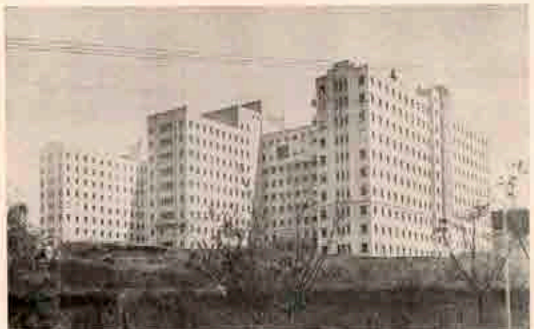
Sistema Monobloco. Hospital das Clínicas da Faculdade de Medicina da Universidade de São Paulo.
