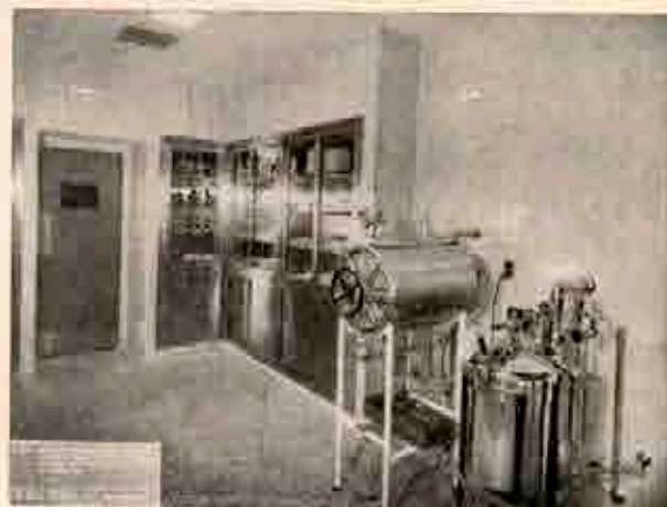
Fig. 13 — Sala de Subesterilização da Chelsea Soldiers Home, Chelsea, Mass. — Esterilizador rápido de Emergência, Lavador e esterilizador de instrumentos, Armários de aço inoxidável e Armário isolado para aquecimento de cobertores e soluções.
