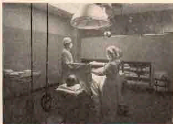
Fig. 32 — Sala de Operação do Hartford Hospital. Sem janelas. Prateleiras sem portas. Galeria de observação sem vidraça. Tubos de O_2 e N_2O descendo do forro. Ver Fig. 31.
