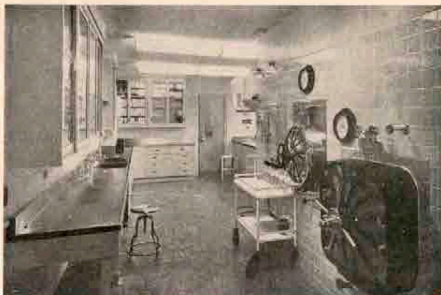
Fig. 38 — Central de Esterilização vista da Sala de Material Esterilizado, Gadsden County Hospital Quincy — Florida — de 100 leitos. Robert and Company Associates-arquitetos. Architectural Record, outubro 1952, pg. 213.
