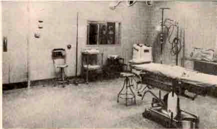
Fig. 33 — Montefiore Hospital — New York — Sala para Neurocirurgia. Sem janelas. Pelo guichê entram as eletrodos do electroencefalógrafo. Pendurado do forro os tubos de O_2 e N_2O . "The Modern Hospital — Fevereiro de 1952 — pg. 71 — Shuman e Lichtenstein — arquitetas.
