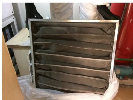
Figuras 2 e 3: Substituição de filtro-bolsa F7 saturado, agosto de 2017. Fonte: Acervo pessoal.
