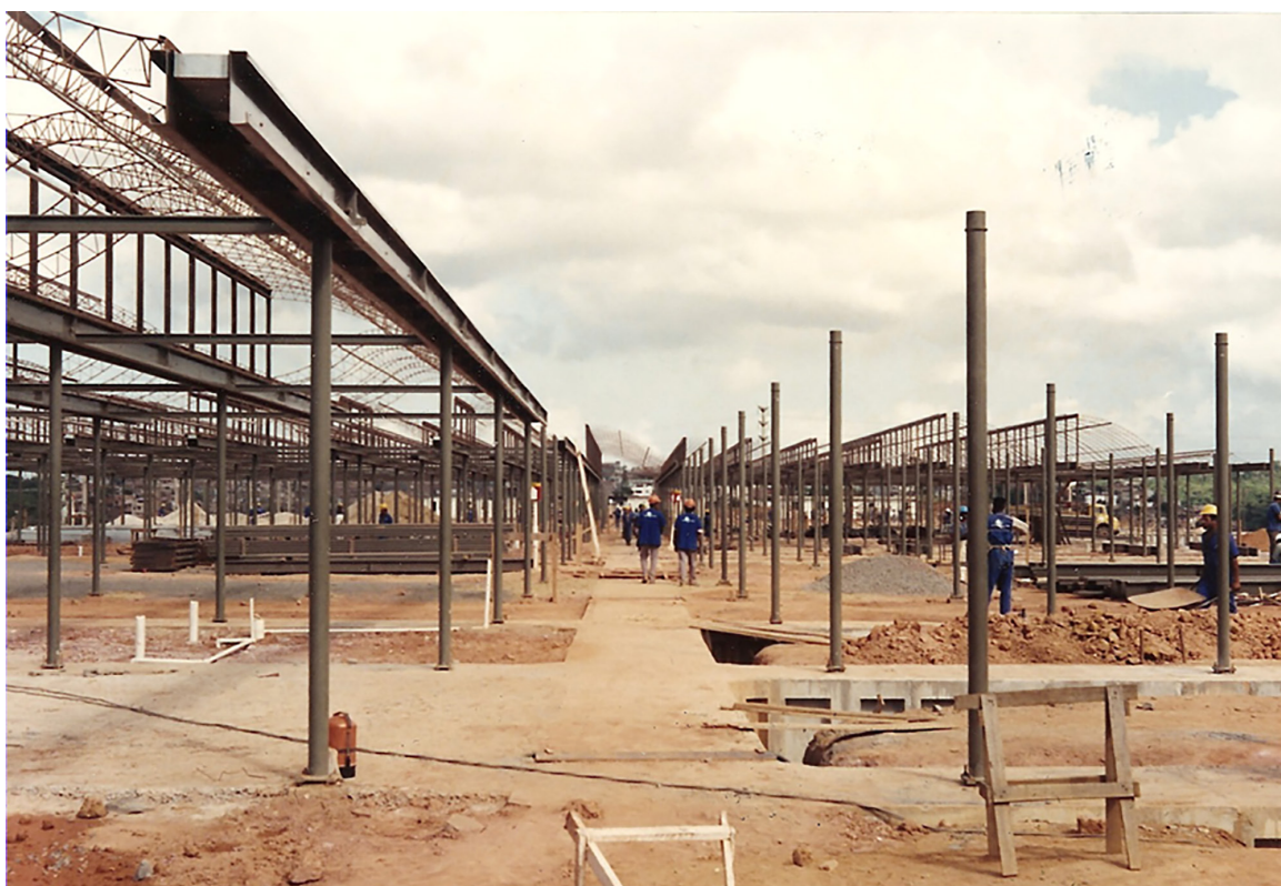
Imagem 13. Sarah/BA – montagem das vigas longitudinais duplas e vigotas transversais de amarração e travamento.
