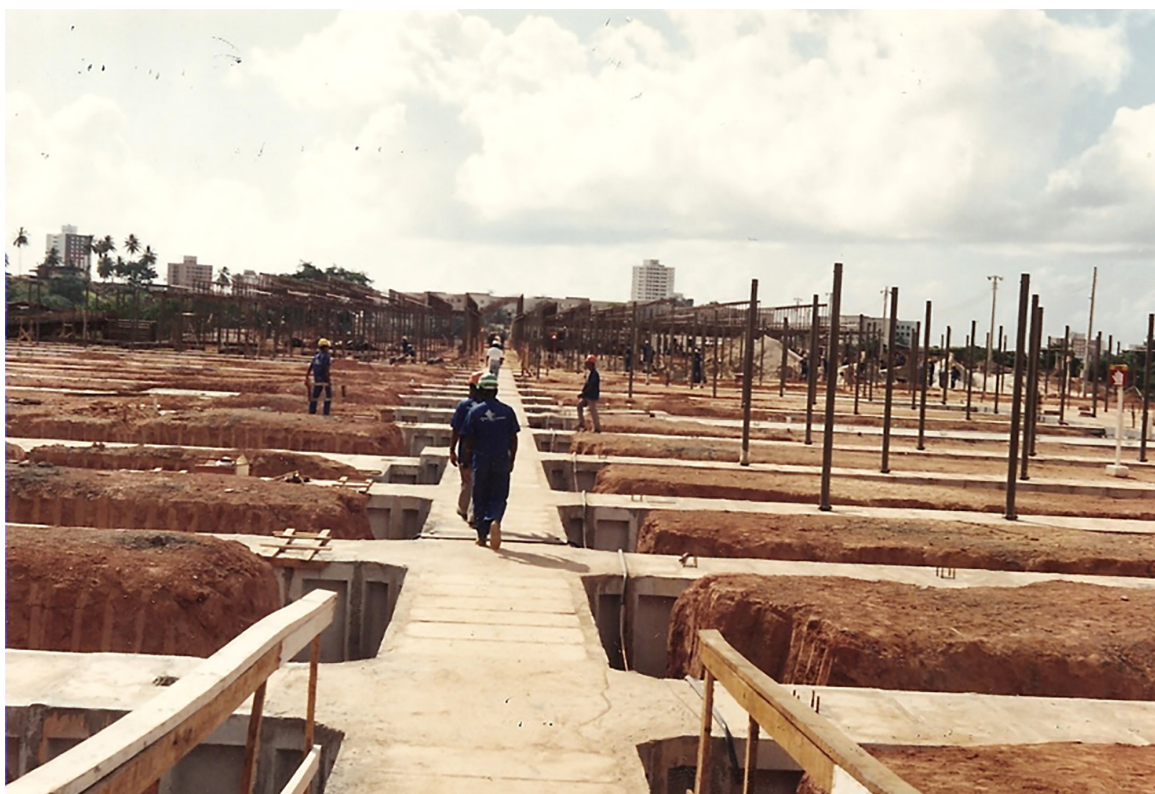
Imagem 11. Sarah/BA – rede de galerias, com esperas para montagem dos pilares tubulares. Fonte. fotografia Haroldo Pinheiro. Acervo do autor.
