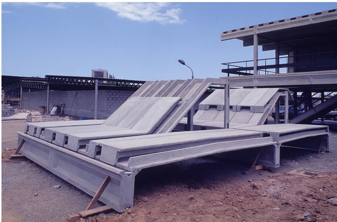
Imagem 08. Sarah/BA (1ª versão) – protótipo do sistema industrializado em argamassa armada (na foto, vigas-calhas, telhas, capas de telhas, “sheds” e capas de “sheds”, sem os pilares), produzido pelo CTRS para o projeto original.
