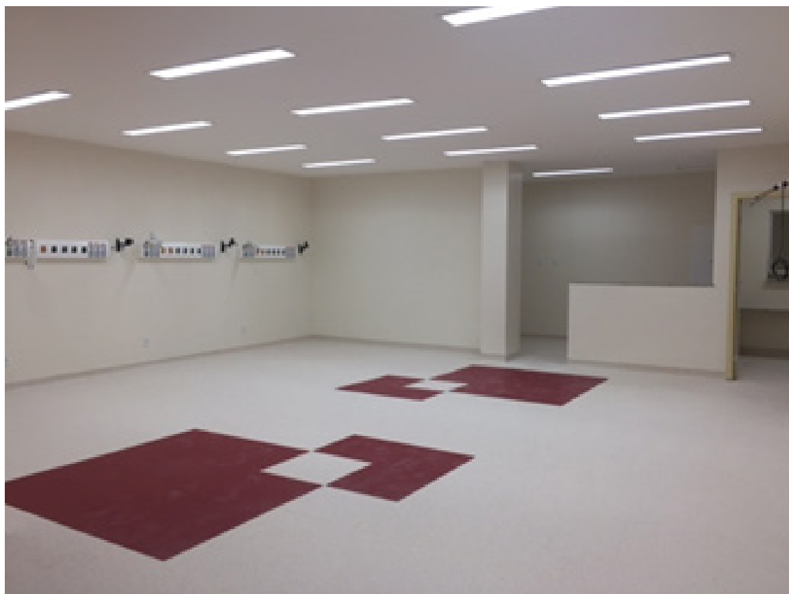
Figura 4. Instalação da manta vinílica. Fonte: Autoria própria (2017).
