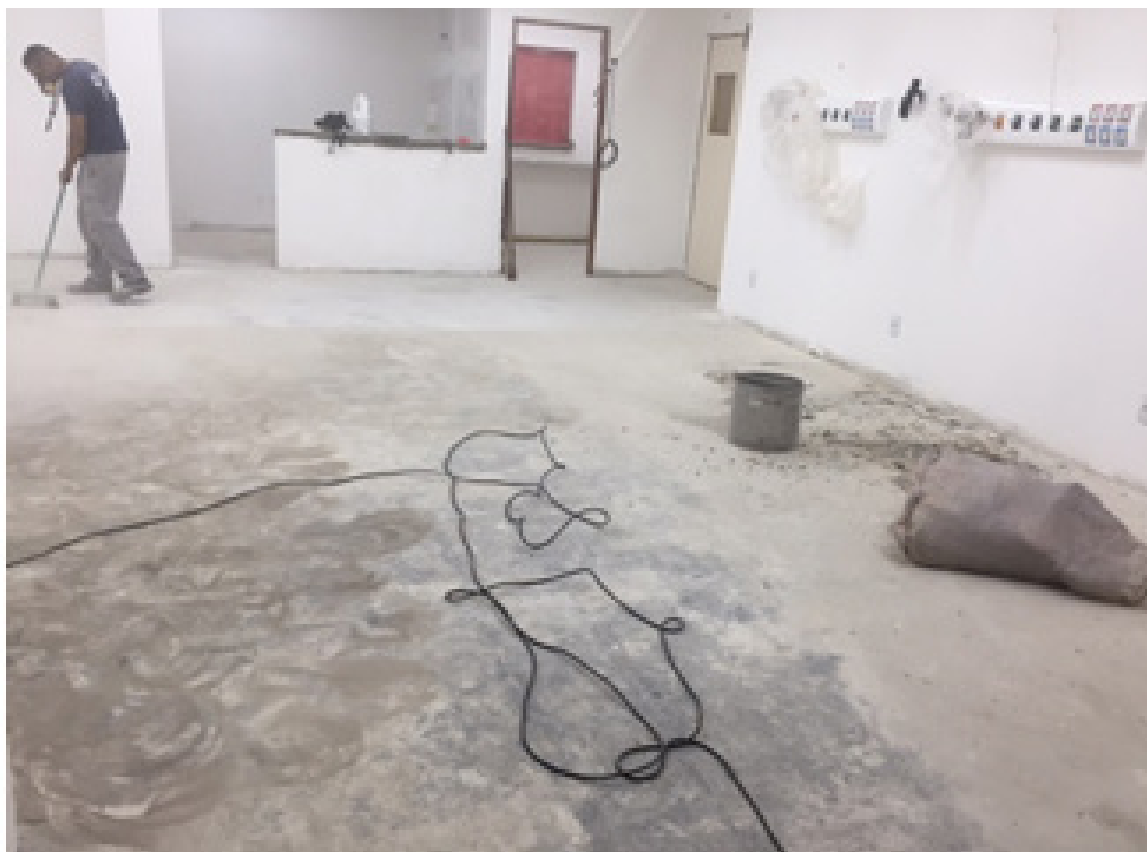
Figura 3. Retirada de sujeira do contrapiso para aplicação da manta vinílica. Fonte: Autoria própria (2017).
