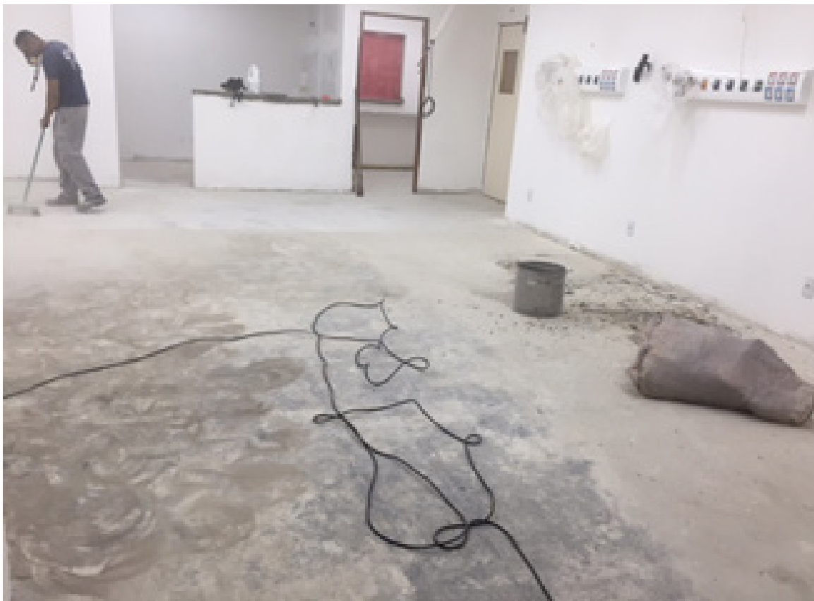
Figura 3. Limpieza de la solera para la aplicación de la lámina de vinilo. Fuente: Autoría propia (2017).
