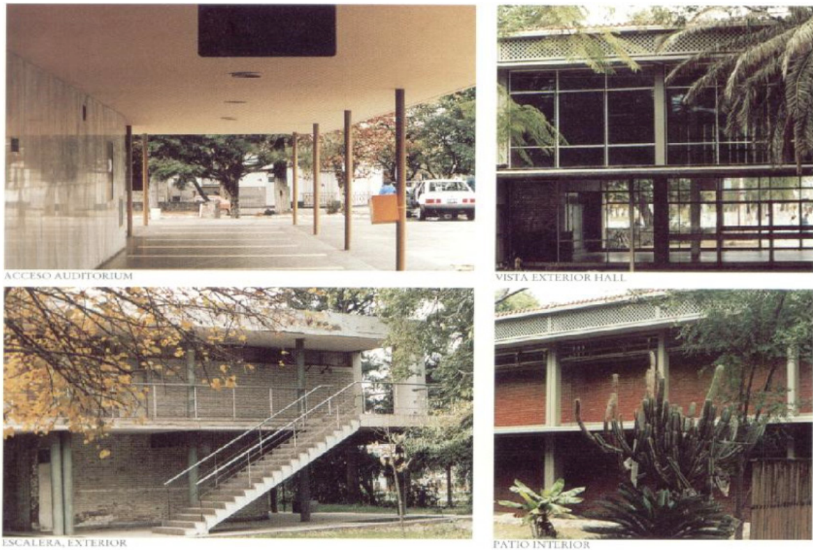
Imagen 8. Galería de Acceso al Auditorio- vista exterior del hall-patio interior con vegetación autóctona. Fuente: Revista S.C.A Nro.173
