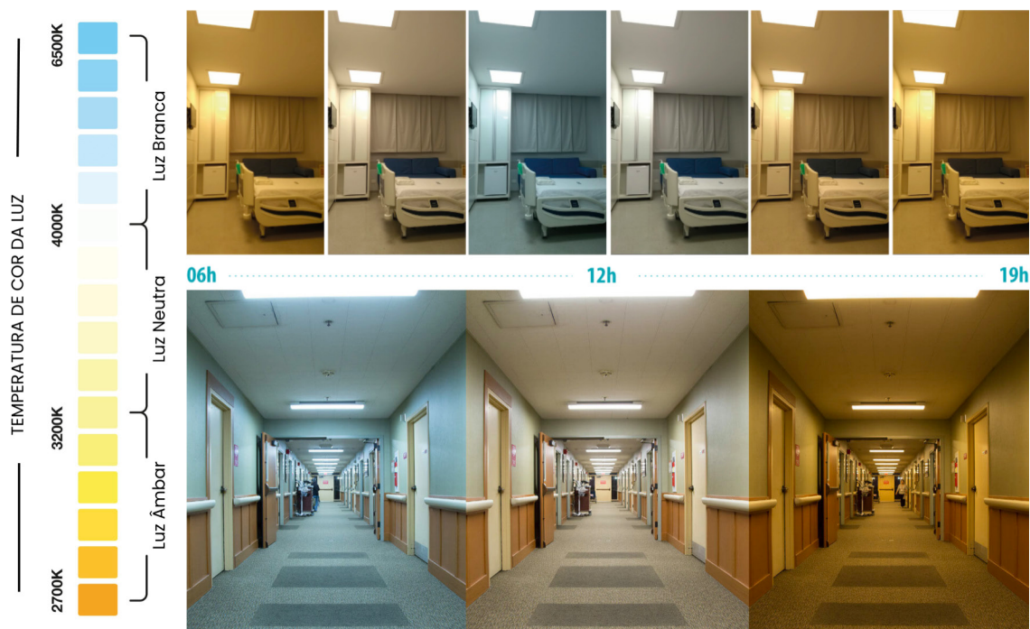
Figura 11. Utilização do sistema tunable white nas acomodações hospitalares dos pacientes e corredores hospitalares. Fonte: Adaptado de lumicenteriluminacao.com.br (2020).
