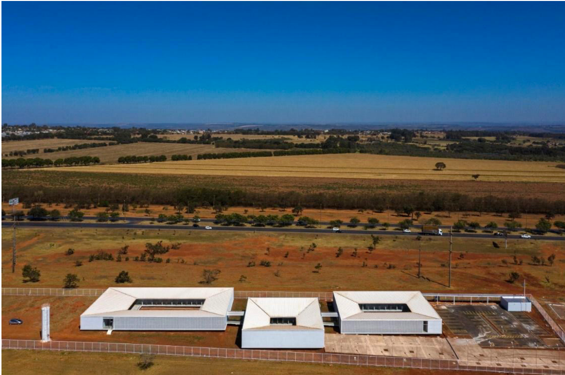
Figura 4. Vista aérea da UBS-5, pela elevação esquerda (nordeste)
