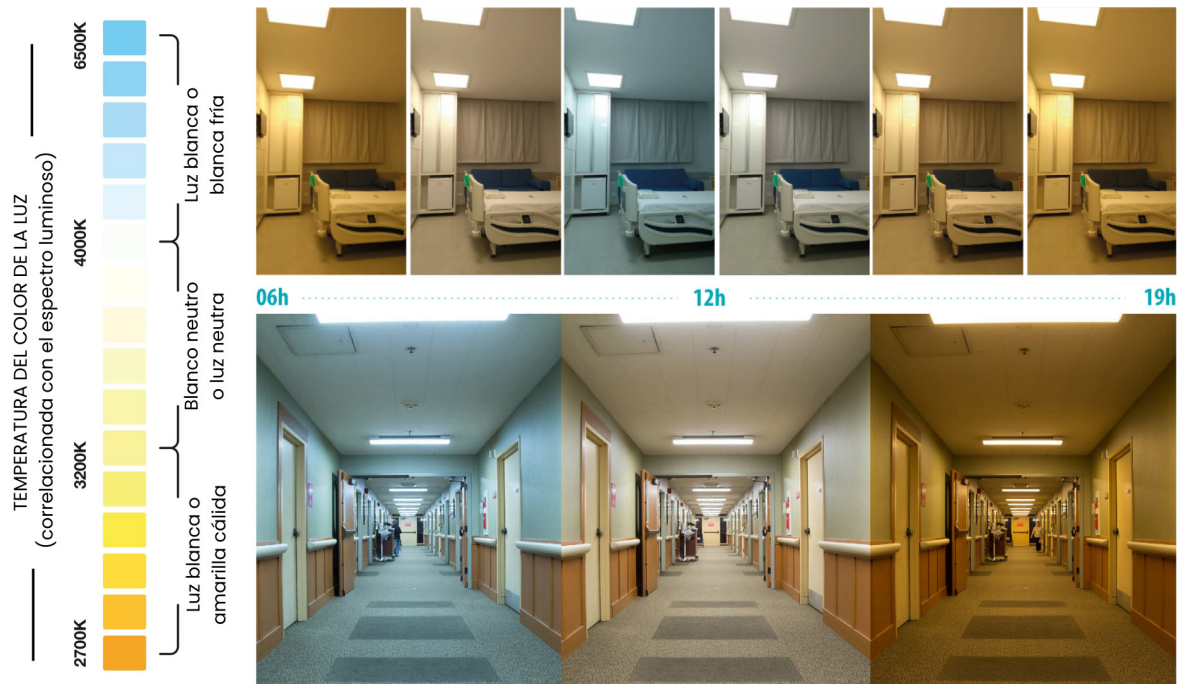
Figura 11. Utilización del sistema tunable white en las habitaciones de los pacientes y en los pasillos de los hospitales. Fuente: Adaptado de lumicenteriluminacao.com.br (2020).
