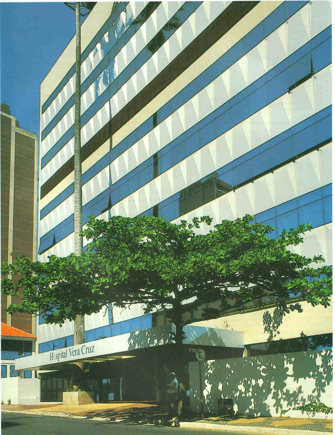
Chapas de alumínio composto dobradas e transformadas em prismas dão forma à fachada
