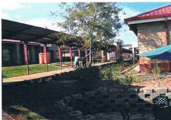
Outra vista da Circulação Geral
