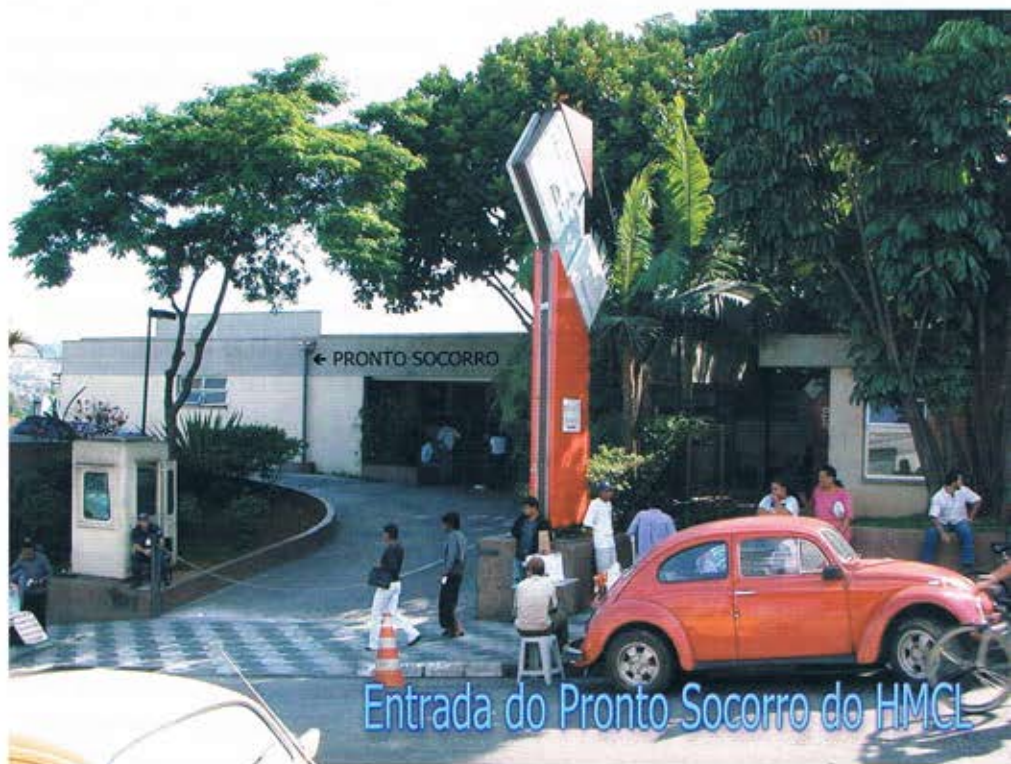
Entrada do Pronto Socorro (antes da Reforma)
